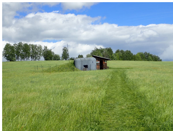
Pohled na rekonstruovaný ŘOPík 111 u Králík
