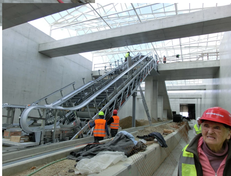
Zasklená podzemní stanice
