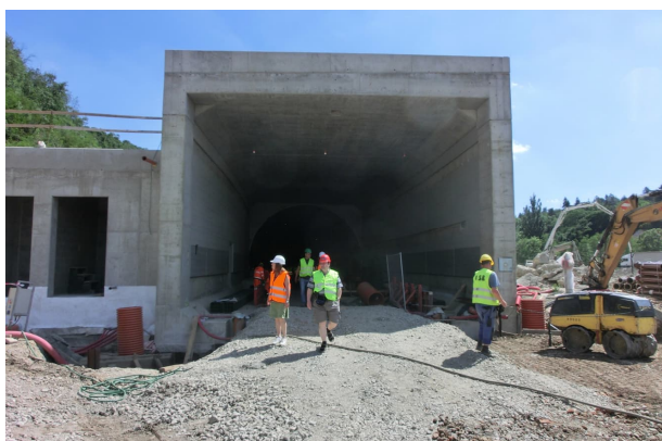
Severní portál tramvajového tunelu
