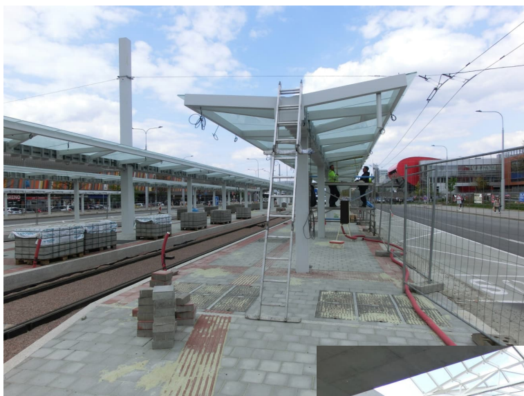
Konečná nové trati před Kampusem
