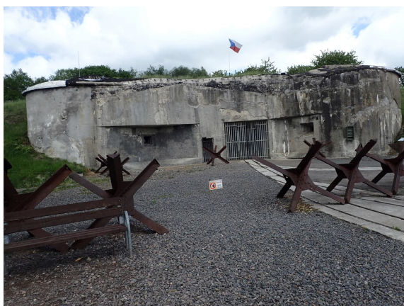
Vchodový srub K-S 12a „U rybníčku“
