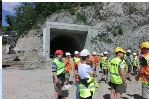
Jižní portál tramvajového tunelu
