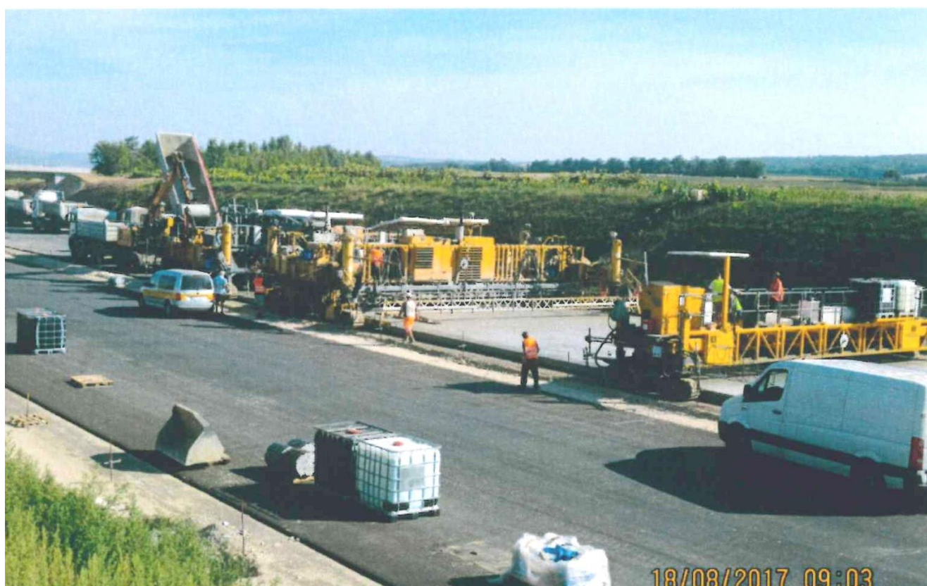
Kladení betonového krytu vozovky na dálnici A5 Nord foto: Hochtief, Alpine
